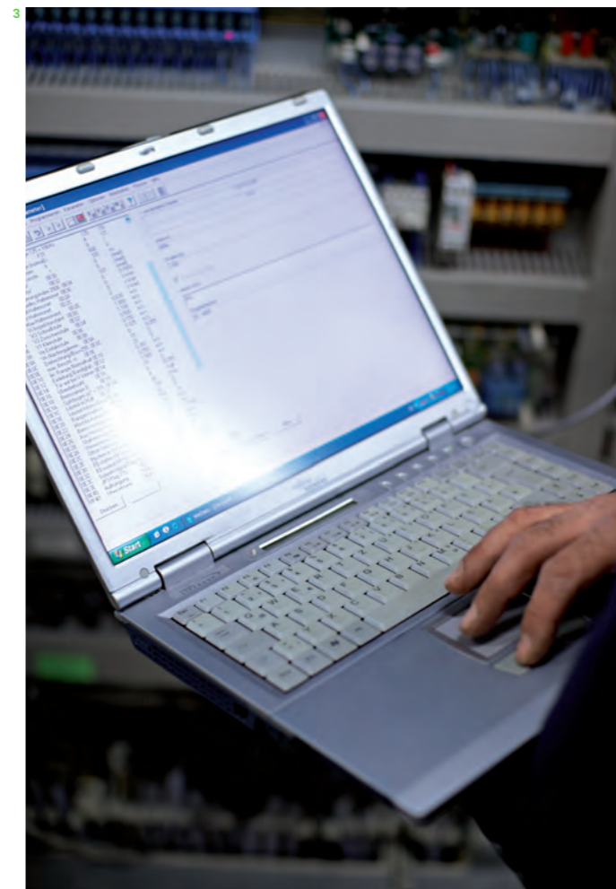
2 Überprüfung einer Schienenbefestigung 3 Datenauswertung Steuerung
