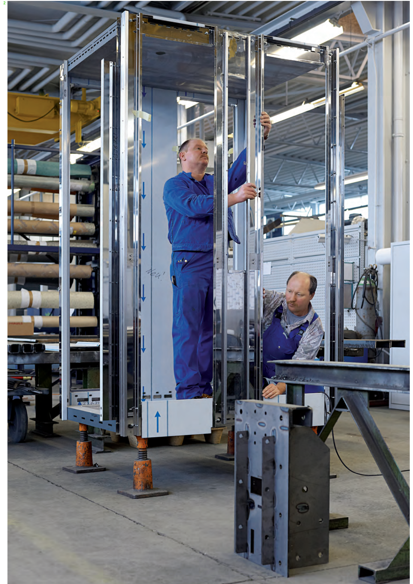
2 Fahrkorbmontage einer Glas Panorama Kabine
